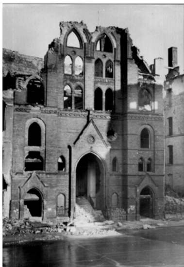
Die Ruinen des Gemeindehauses in Berlin-Schmidtstraße
